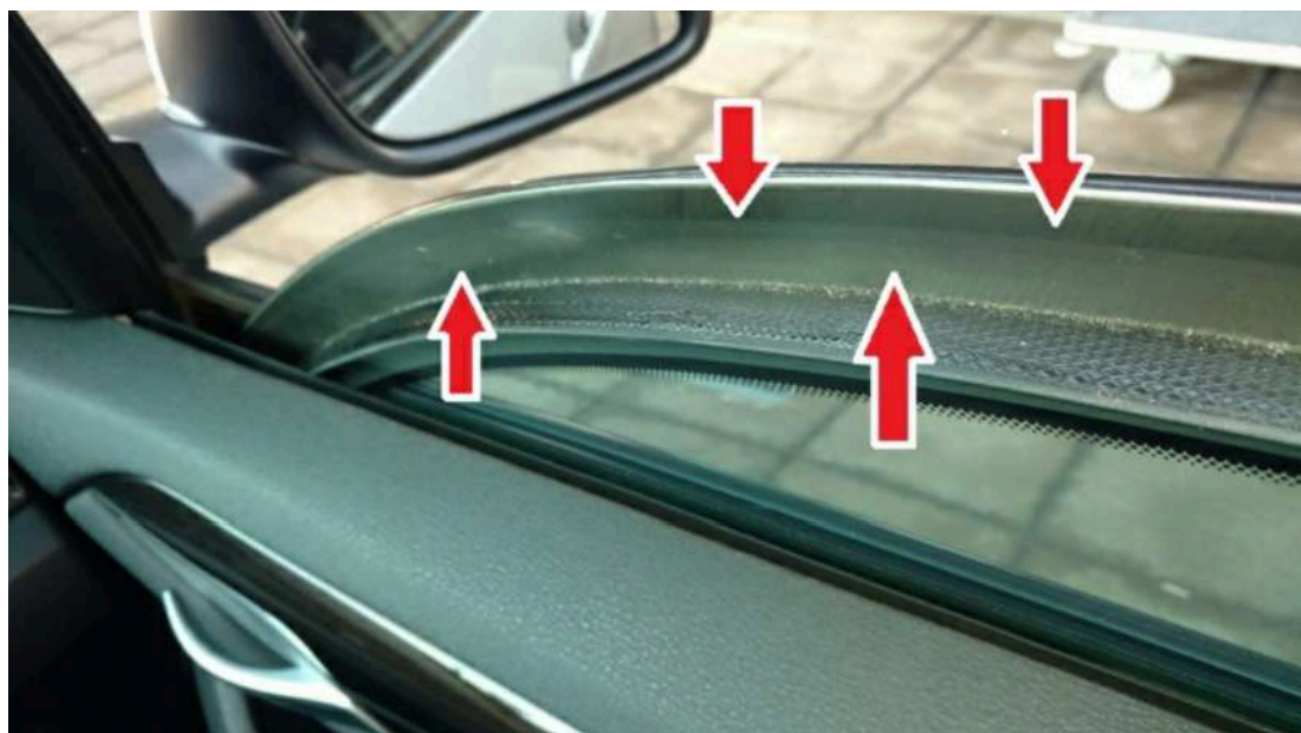
Figura 6 - Detalhe do reforço em aço na região do offset do vidro da porta dianteira.
